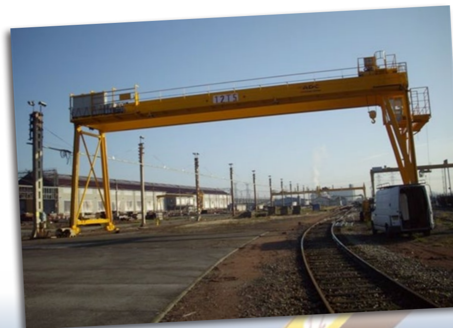
Préparation de rails (EIMM Chambly): Charge 12,5t, portée 27m, classement élevé (M7)
